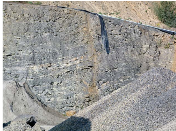
Abb. 2: Aufgeschlossene Störung plattigen bis bankigen Kalksteinen der Trochitenkalk-Formation (moTK) an der westlichen Abbauwand im Steinbruch Knittlingen / Bretten (RG6918-1). Im Bereich der Störungszone sind Faltung und Schleppung der Kalkstein zu erkennen.
