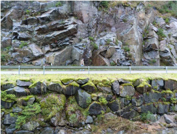
Abb. 1: Das Gestein des Erzenbach-Komplexes (axE) entlang der Straße (L 405) von Schenkenzell nach Reinerzau im Tal der Kleinen Kinzig. Das dunkelgraue Gestein zeigt eine weitständige Klüftung und wurde hier am unteren Bildrand als Hang- und Wasserbaustein eingesetzt.
