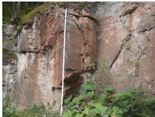
Abb. 2: Aufgelassener Steinbruch Sulz a. Neckar-Bergfelden (Birkenhau, RG 7618-6): Ehemalige NE-Abbauwand aus hartem, dickbankigen, weitständig geklüfteten Schilfsandstein (Renfrizhauser Sandstein = Nutzschrift), darüber mäßig harter, dünnplattiger bis dünnbankiger, unregelmäßig aufspaltender, engständig geklüfteter Sandstein (= Abraum, Messlatte 3 m hoch).
