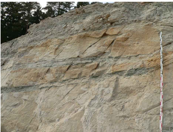
Abb. 1: Nahaufnahme der Abbauwand in der Sandgrube Rosenfeld-Brittheim (RG 7718-2); die Sandsteine sind schwach gebunden und wittern rasch auf.
